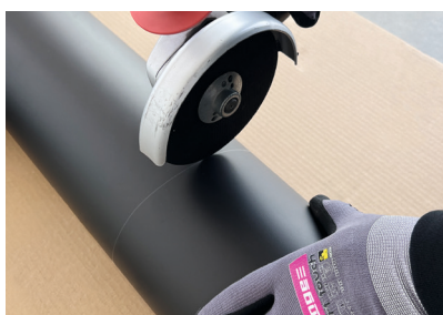
ABB. 5.3 Kürzung des Rauchrohrs
