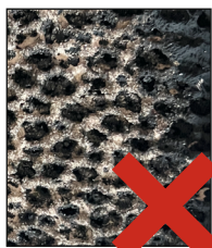
ABB. 6.2 Zu reinigende Kata- lysatoroberfläche
